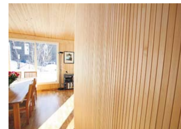
SVEIS FRA SVEITS: Det er det sveitsiske firmaet Tschopp Holzbau som har levert massivtrehuset i Heggedal. Vegg og takelementene består av bord sammenføyet med trebybler som er presset inn i forbrorede hull.
