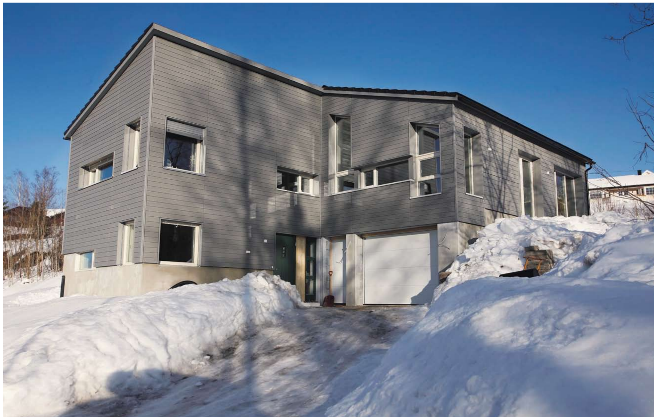
BYGGEKLOSS: Huset i massivtre er importert fra Sveits og ble levert i moduler. Da grunn-
